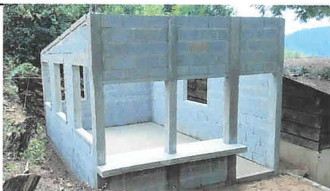
FOTO 3: EN LA COCINA SE CONSTRUYERON PAREDES DE BLOCK CON REFUERZO DE COLUMNAS DE CONCRETO, TALLANDO LA SISA DE UNIÓN DE BLOCK PARA DARLE MEJOR PRESENTACIÓN AL BLOCK
