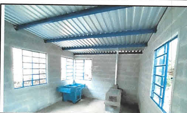
FOTO 4: SE CAMBIO LA ESTRUCTURA Y LAMINA COLOCANDO COSTANERA DE METAL DE 2 X 4 Y SE COLOCÓ LAMINA TROQUELADA CALIBRE 26 TANTO EN LA COCINA COMO EN LOS SANITARIOS.
