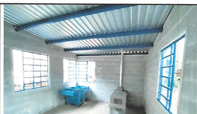
FOTO 4: SE CAMBIO LA ESTRUCTURA Y LAMINA COLOCANDO COSTANERA DE METAL DE 2 X 4 Y SE COLOCÓ LAMINA TROQUELADA CALIBRE 26 TANTO EN LA COCINA COMO EN LOS SANITARIOS.
