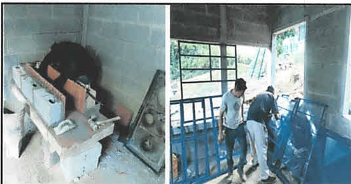
FOTO 6: CONSTRUCCIÓN DE COCINA AHORRADORA E INSTALACIÓN DE VENTANAS Y PUERTAS DE METAL.
