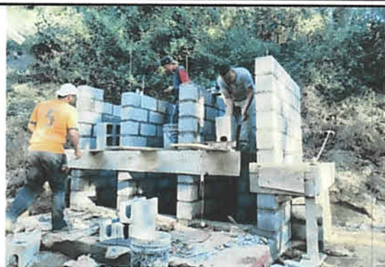
FOTO 2: LAS PAREDES DE DIVISIÓN DE SANITARIOS SE CONSTRUYERON CON BLOCK SÓLIDO DE 19 CMS DE ANCHO PARA UNA MEJOR FUNDICIÓN DE LAS COLUMNAS TIPO PIN EN TODOS LOS AMARRES
