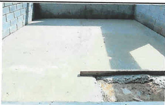
FOTO 5: SE PROCEDIÓ A PREPARAR Y COMPACTAR LA BASE PARA LA FUNDICIÓN DE PISO DE CONCRETO EN COCINA Y SERVICIOS SANITARIOS
