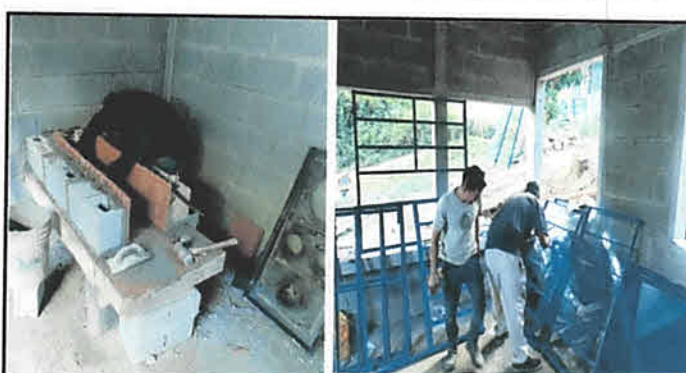
FOTO 6: CONSTRUCCIÓN DE COCINA AHORRADORA E INSTALACIÓN DE VENTANAS Y PUERTAS DE METAL.
